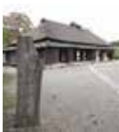
江戸時代末期に建てられた移築古民家「旧遠藤家住宅」の見学もできる
